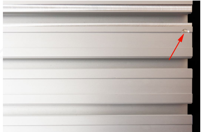
Bild 9: Markierung der oberen Anschlagfräsung.
