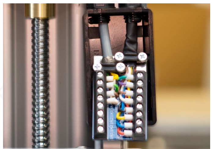
Bild 6: Fertig angeschlossene Litzen des Steuerkabels
