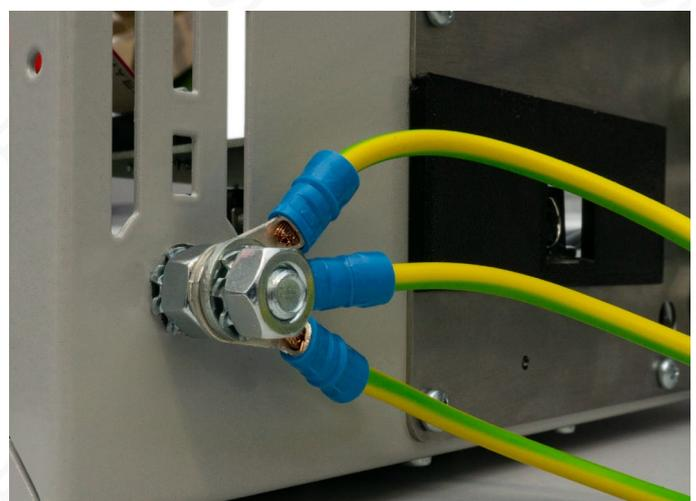
Bild 24: Erdungsverschraubung mit aufgelegten Kabeln
