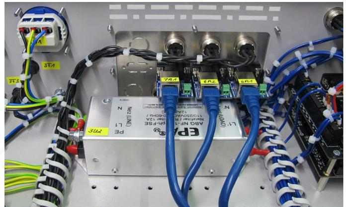
Bild 2: Netzfilter vor Ausgangsblende
